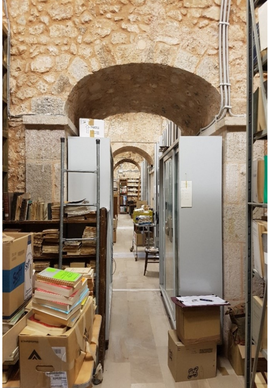
Stato dei luoghi del primo livello prima dell'intervento
